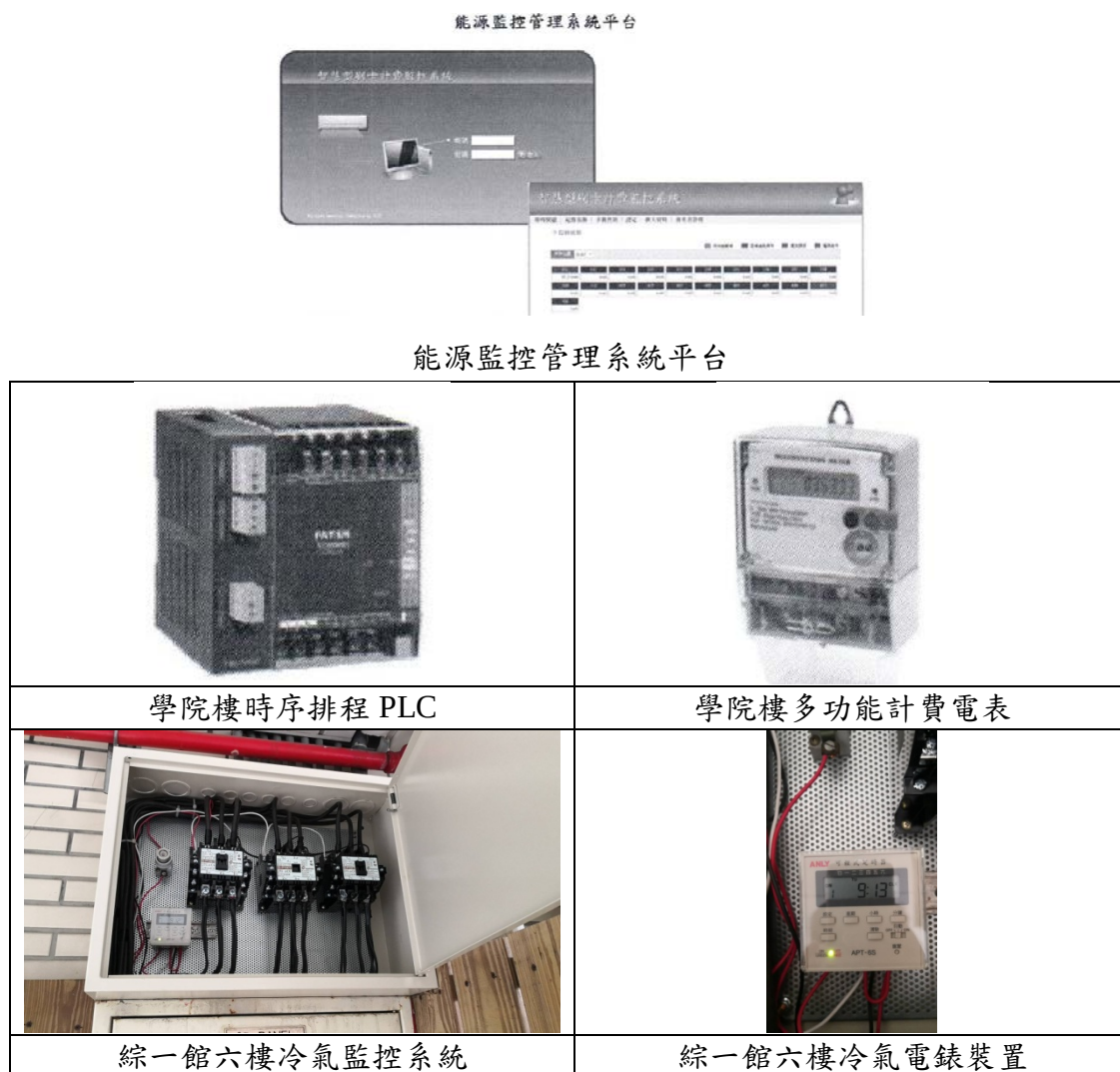
圖 3-3-3 能源監控管理系統平台與設備
